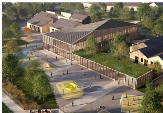
Le projet de réhabilitation de l'école Geneviève Grattier, tourné vers la transition écologique, prend forme à Saint-Malo-de-Guersac. Le bâtiment sera reconstruit en utilisant une structure en bois et sera équipé d'une toiture photovoltaïque avec une capacité de 94 kWc, en auto-consommation collective sur le patrimoine communal. De plus, un préau et une cour seront végétalisés pour favoriser un environnement plus vert.
