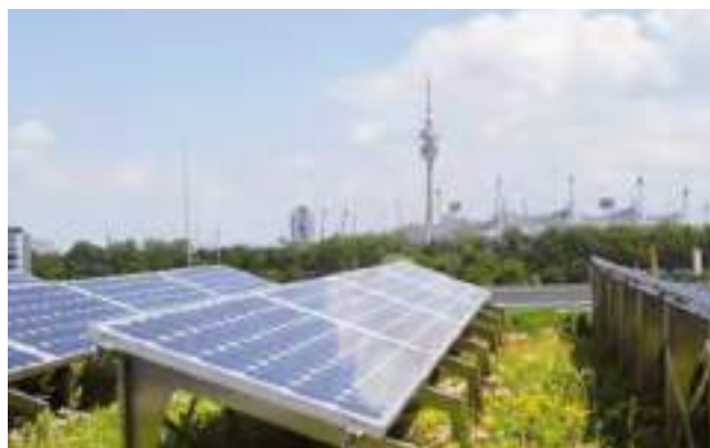
Toiture biosolaire Source : Ecovégétal
