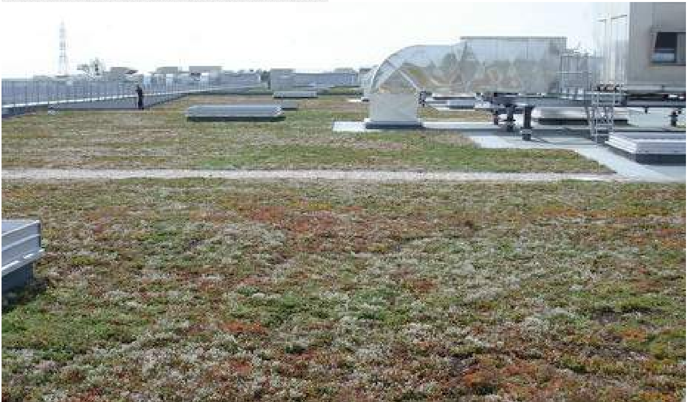
Toiture extensive du parc des expositions à Villepinte Source : Milena Chessa
