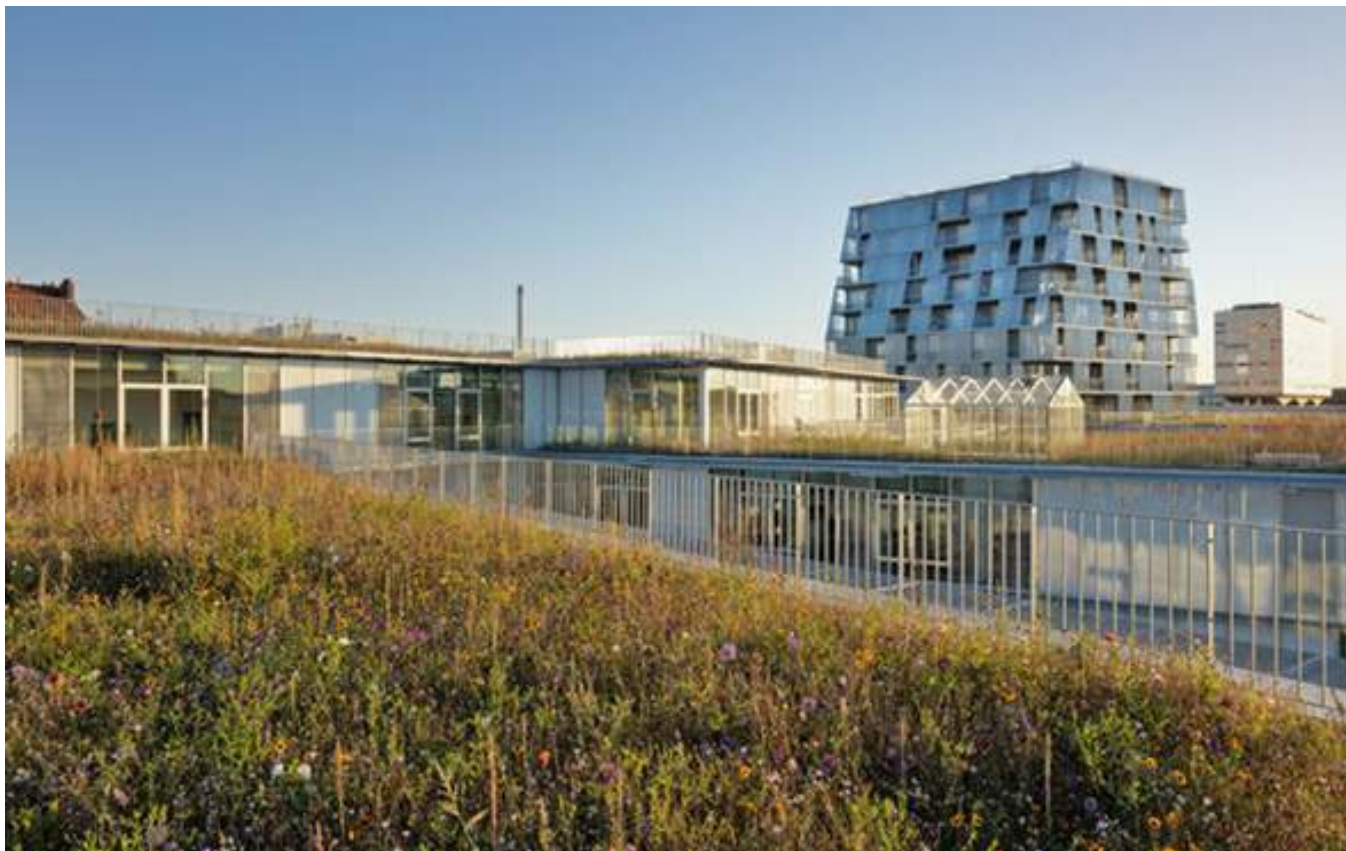
Toiture semi-intensive du groupe scolaire Rosalind-Franklin à Ivry-sur-Seine Source : Takuji Shimmura
